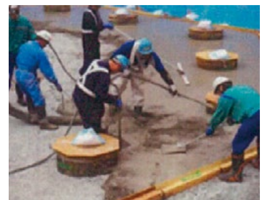
開発したリミックスコン(再資源化)による工事
